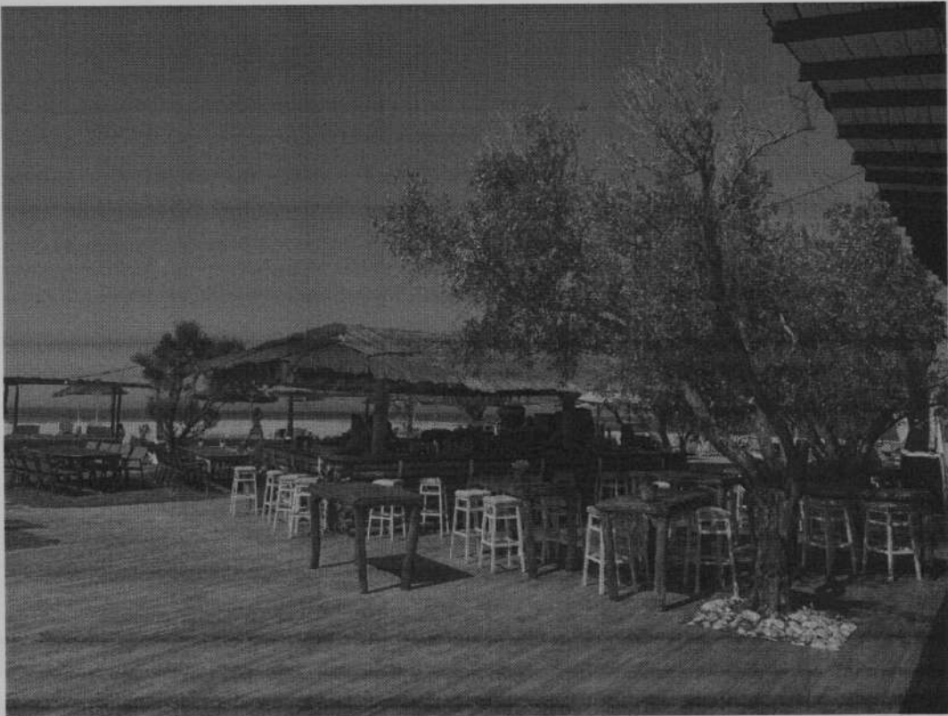
Φωτογραφία 2: Ξύλινη κατασκευή – μπαρ (αυτοψία 06-09-2024)
