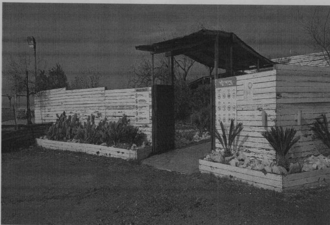
Φωτογραφία 3: Είσοδος αναψυκτήριου – Ξύλινη περίφραξη (αυτοψία 19-02-2024)
