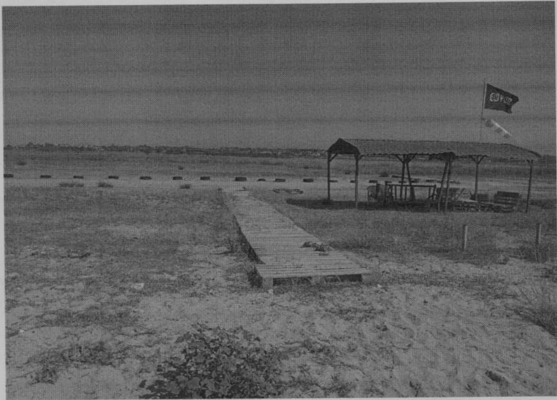
Φωτογραφία 13: Κατασκευές εντός αμμοθινικού οικότοπου (αυτοψία 06-09-2024)
