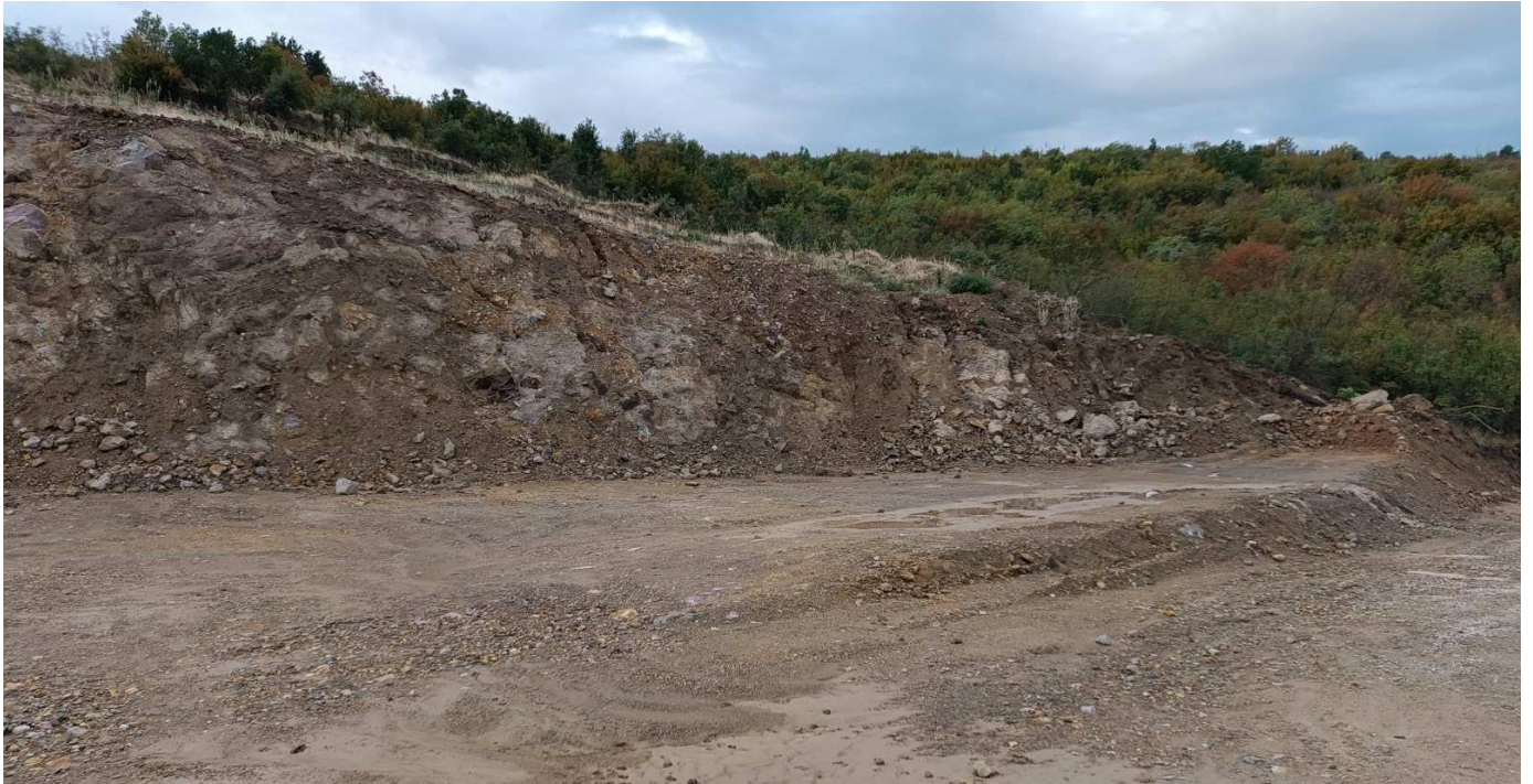
ΦΩΤΟ 3: Άποψη τμήματος του πρανούς της εκσκαφής από κοντινή απόσταση.
