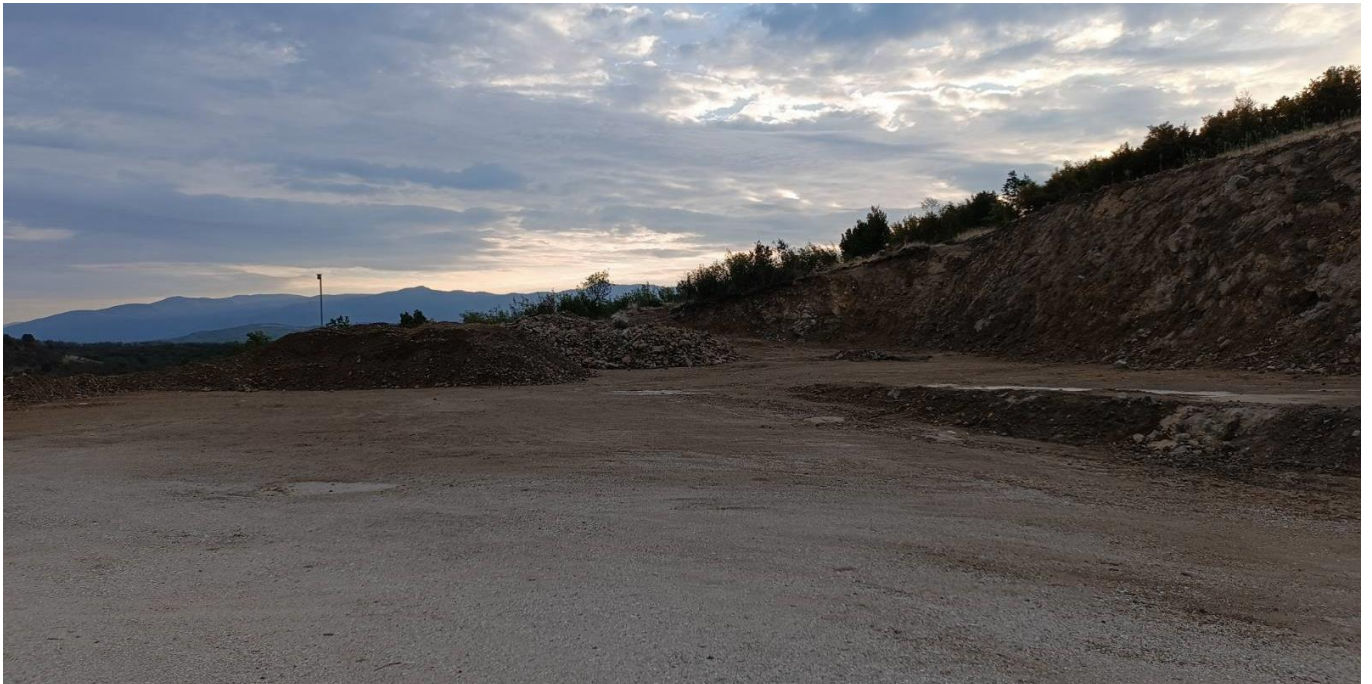
ΦΩΤΟ 2: Γενική άποψη της υπό διαμόρφωση πλατείας, στα χαμηλότερα υψόμετρα του λατομικού χώρου. Διακρίνεται τμήμα του πρανούς της εκσκαφής, καθώς και τα υλικά που προκύπτουν από τις λατομικές εργασίες.
