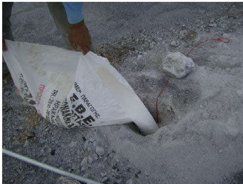
Σχήμα 14: Γόμωση διατρημάτων με φυσίγγια και ANFO.
